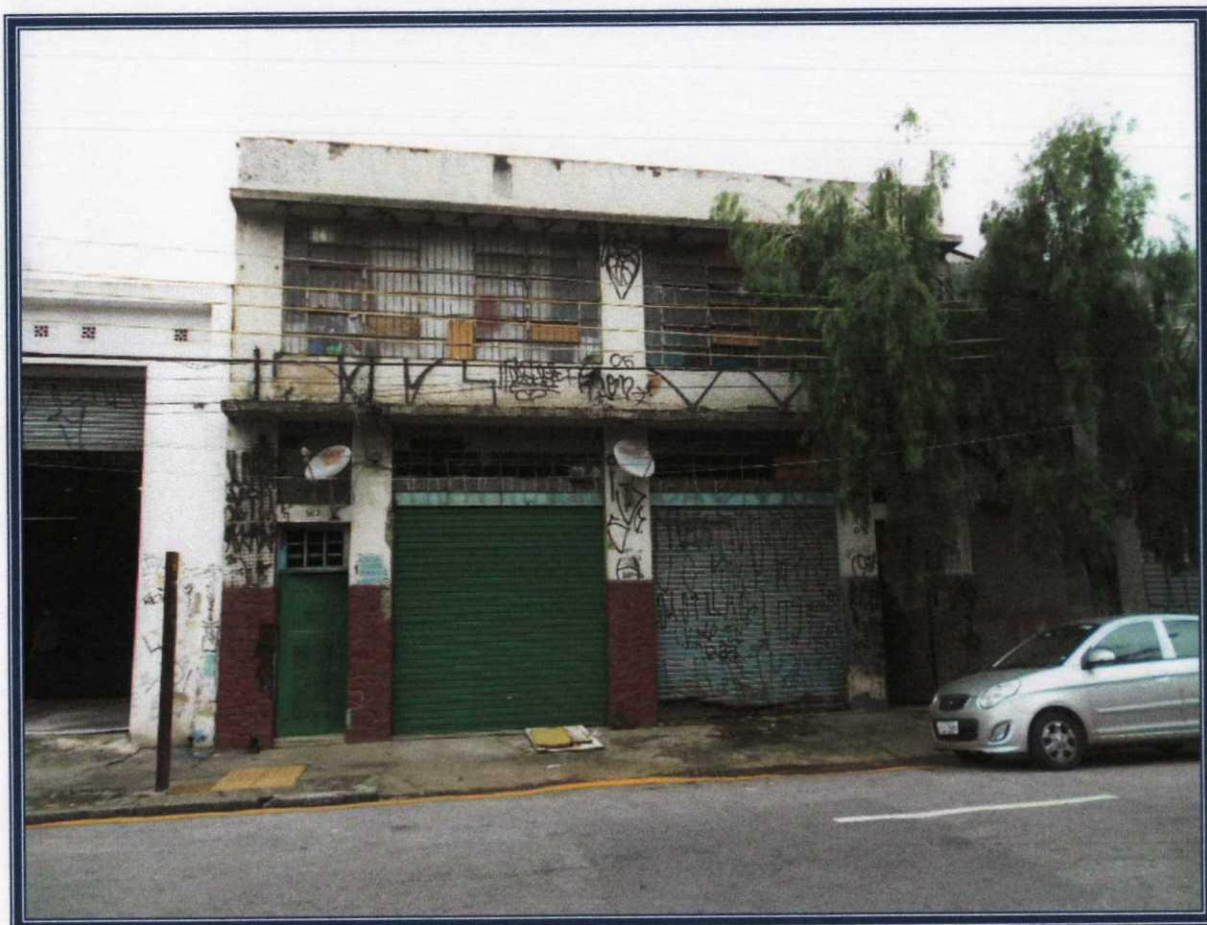
Vista frontal do imóvel avaliando.
