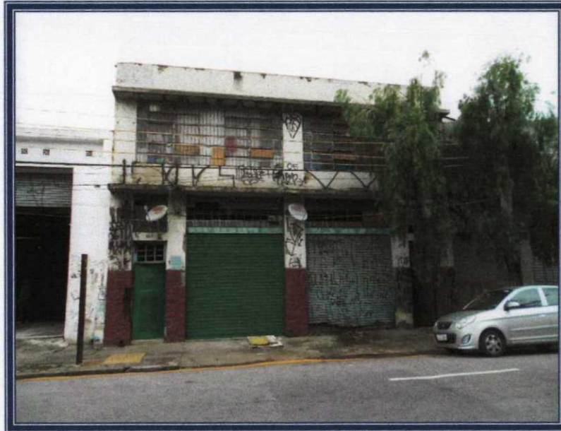
Vista da frente do imóvel avaliando.
